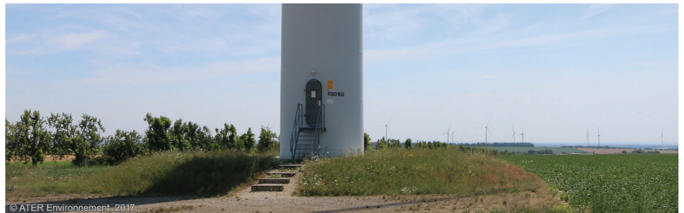
Fig. 264 : Pied d'éolienne enherbé
